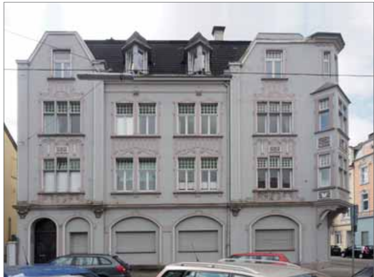
Bahnhofstraße 43, 2017 Ansicht Nord-Fassade (Stadt Hattingen)
