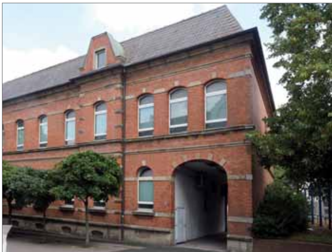
Ehemaliges Post- / Fernmeldegebäude, 2017 (Stadt Hattingen)
