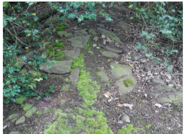
Abb. 36: Sandsteinmauer unterhalb der Weste im weiteren Verlauf zerfallend, Foto 2017
