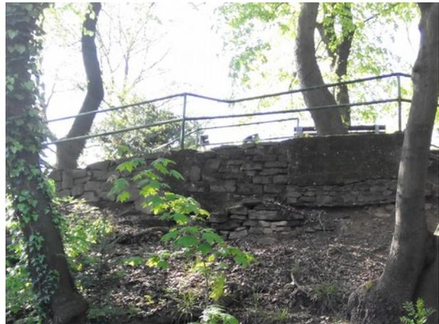
Abb. 65: Friedrichsberg, Sandsteinmauern mit Schäden und Betonflicken, Foto 2017
