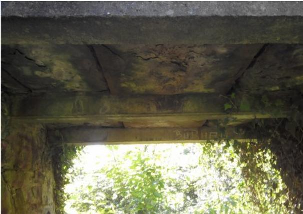
Abb. 136: Belvedere Brücke, Untersicht Träger und Sandsteinplatten, Foto 2017
