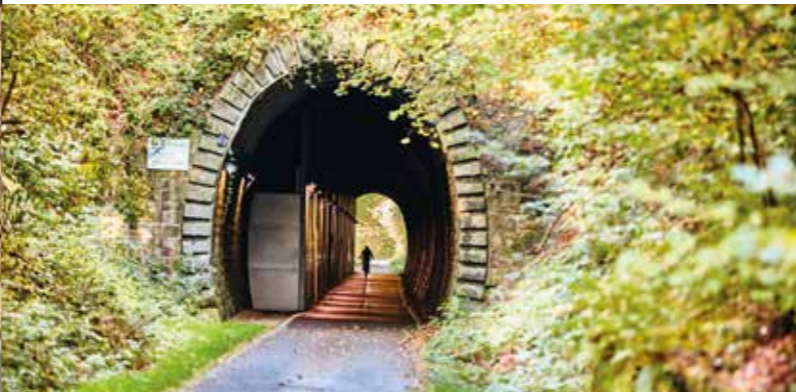
Höhsieper Tunnel, Hückeswagen
