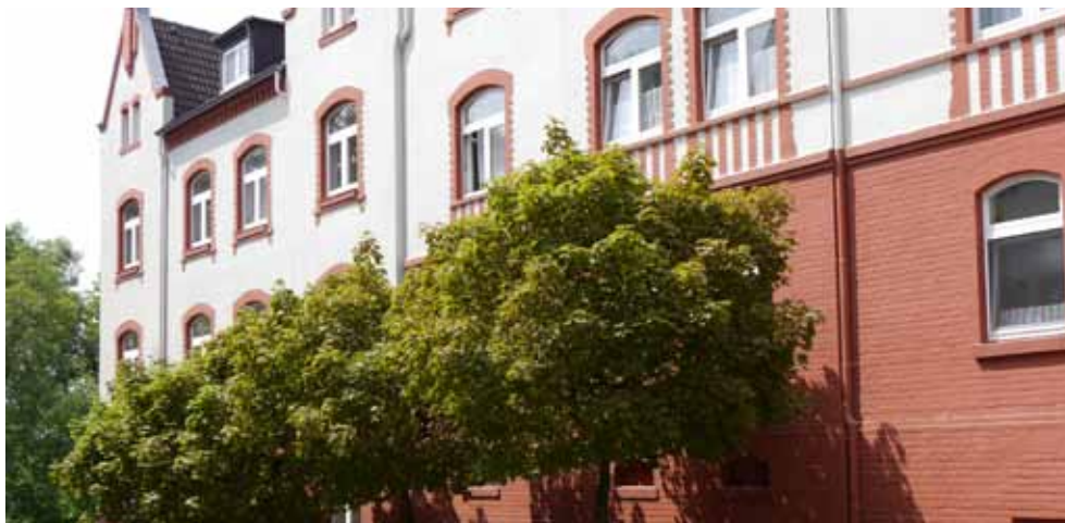
Abb. 17: Bebauung an der Henschelstraße
