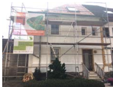
Das Gebäude Ringstraße 35 während der Sanierung.
