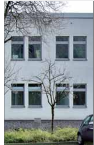
Amtsgericht, Detail der Fassade (Stadt Hattingen)
