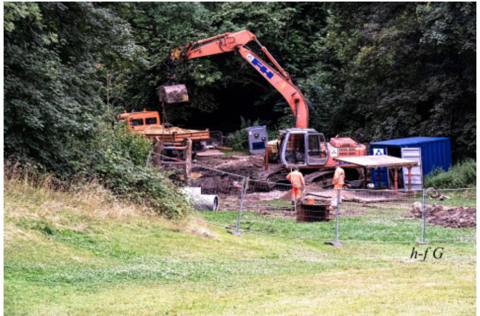
Arbeiten an der Entwässerung im unteren Parkbereich.
