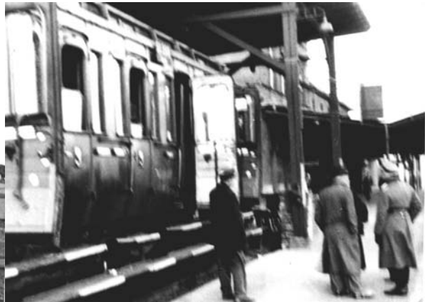
Bahnhof Hattingen, kurz vor der Abfahrt zur Sammelstelle nach Dortmund.
